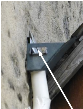
Un chéneau bien fait avec un exutoire, malgré une gouttière en plastique
