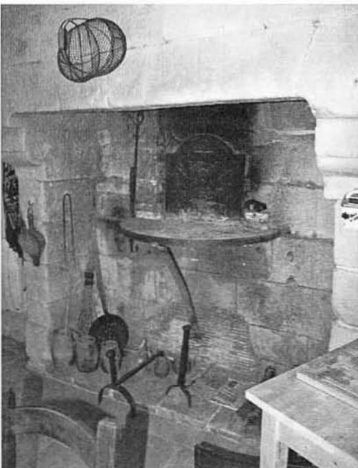
*Un foyer rehaussé en fer, basculant si nécessaire*
