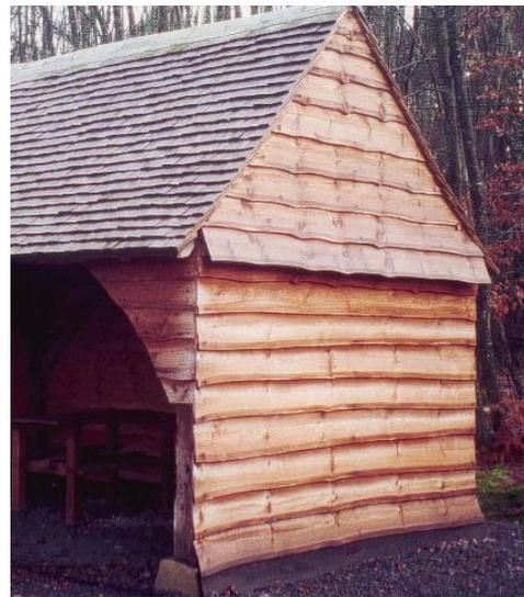
*Photo-fig.8 : Toit de bardeaux fendus, faitage de terre cuite et embarrures de chaux, voligeage de pin non déligné.*
