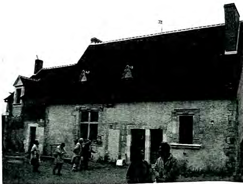
LE PRIEURE DE CHENUSSON EN COURS DE RESTAURATION
