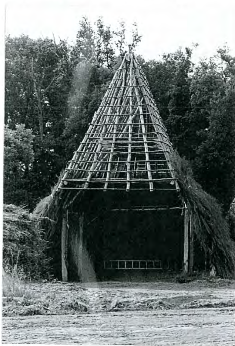
LE HANGAR DE BRUYERE A LA DEUSERIE PENDANT SA CONSTRUCTION, EN 1995
