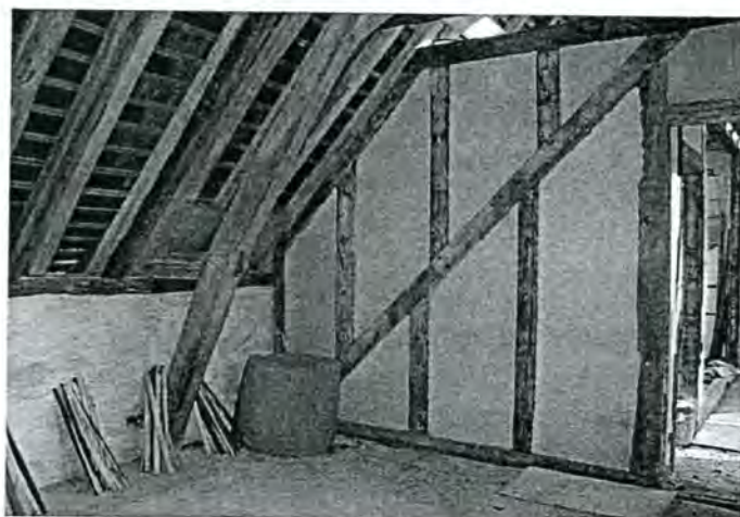
isolation de toiture et cloisons en chanvre
