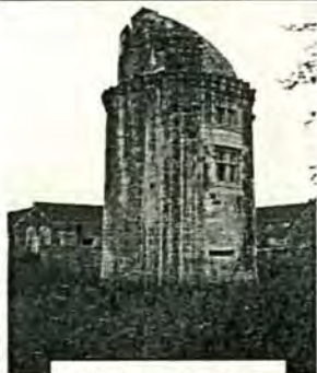
Donjon restauré vu côté extérieur
