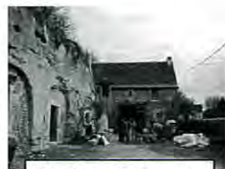
Site du stage badigeon et enduit terre du 14.03.09
