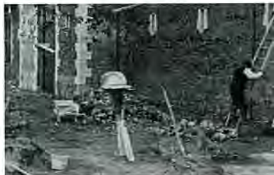
Au premier plan, debout "l'oiseau" appareil en bois servant à monter les mortiers et pierres sur un échafaudage. Utilisé dès le Moyen Age jusqu'au XX ème siècle
