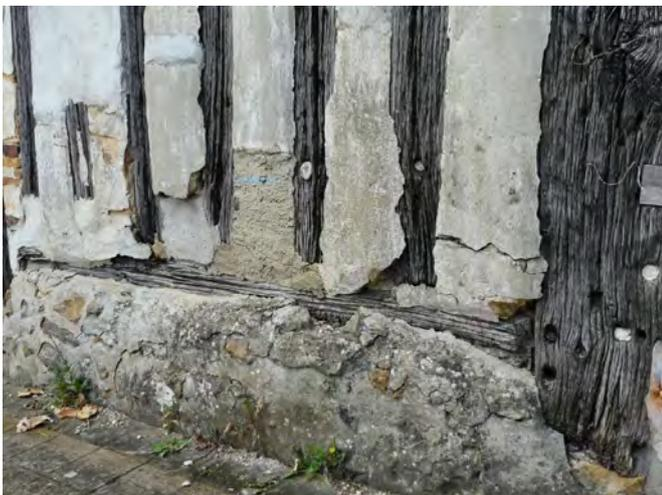
Autres causes plus récentes de la dégradation des pans de bois : l'emploi de matériaux inappropriés tels que les ciments sur le bois et le torchis.
