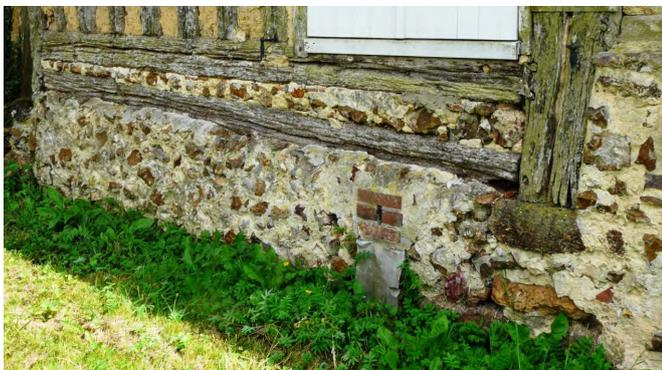
La sablière basse d'un pan de bois est le plus souvent fragilisée par le ruissellement vertical des eaux de pluie qui provoquent son pourrissement ainsi que celui de la partie inférieure des colombes qui viennent s'y encastrent.
