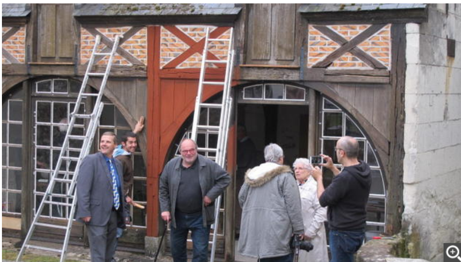
Satisfaction et félicitations du maire Éric Carnat et de son conseiller culture Xavier Trotignon lors de cette visite du chantier de réhabilitation des Crôts.
