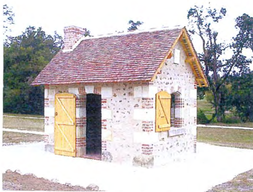
La loge de Thilouze complètement remontée
