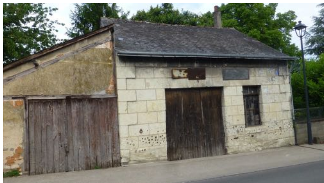
Les trous servaient de gabarit aux mèches
