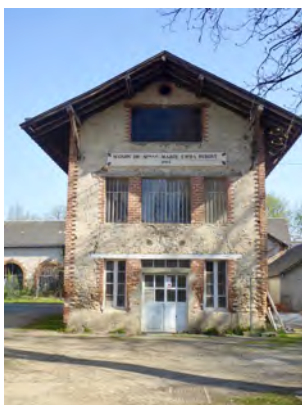
Le pavillon de Madame Hébert. 1842 indique l'année de construction.
