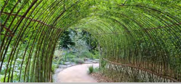
Suggestions pour un tunnel de 6 m de long, ce qui correspond à la longueur des fers: 20 fers à béton de 8 mm de diamètre, tous de 6 m de long. Bien enfoncer dans le sol de 30 cm environ. 3 de ces fers ne sont pas plantés mais fixés horizontalement pour solidifier l'ensemble.
